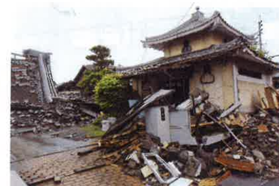
益城の住宅倒壊現場
